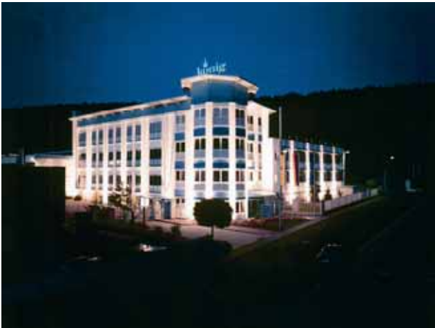
Das Verwaltungsgebäude der König-Unternehmen in Wertheim (Main-Tauber- Kreis).
